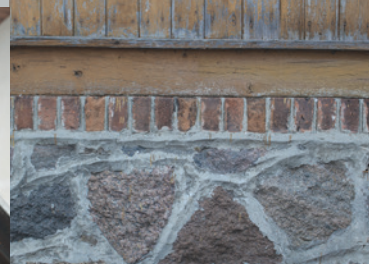
Fundament z łamanego kamienia polnego, Natolin, gm. Osieck
