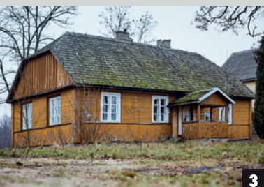
3 Dach naczółkowy, kryty gontem, Kuflew, gm. Mrozy
