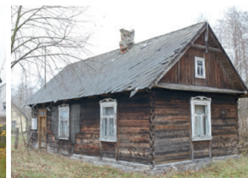
Dom w konstrukcji zrębowej, Czarnowiec, gm. Osieck
