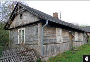
4 Dach dwuspadowy z okapnikiem w ścianie szczytowej, Stara Huta, gm. Garwolin
