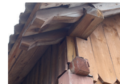
Konstrukcja ze ścianą kolankową, Ponurzyca, gm. Celestynów
