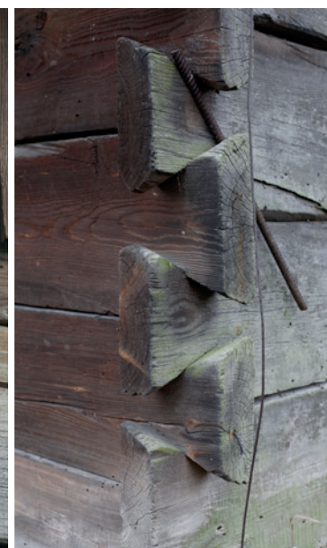
Zawęgłowanie naroży w konstrukcji zrębowej
