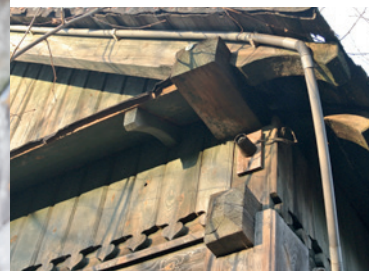
Konstrukcja ze ścianą kolankową, Czarnowiec, gm. Osieck
