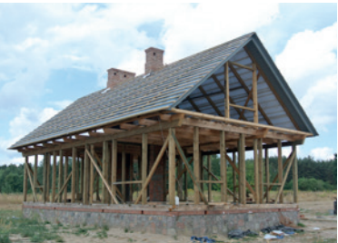
Szkielet domu w konstrukcji ryglowej
