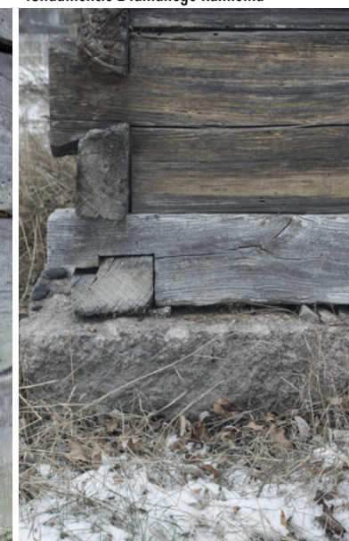
Osadzenie podwaliny dębowej na kamieniach w konstrukcji zrębowej
