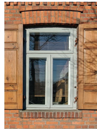
Okno skrzynkowe w budynku ceglany, Kołbiel
