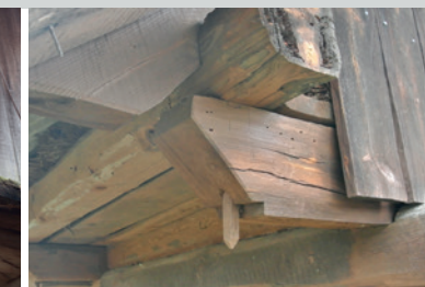
Konstrukcja okapu dachu w budynku gospodarczym, Czarnowiec, gm. Osieck
