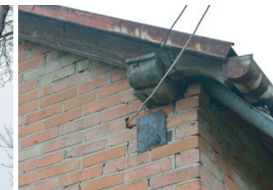
Konstrukcja ze ścianą kolankową, Czarnowiec, gm. Osieck
