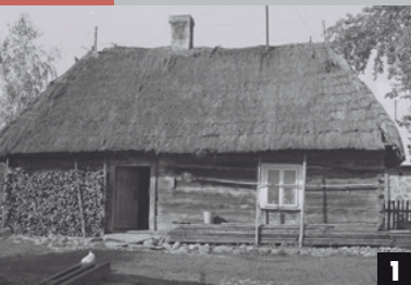
1 Dach czterospadowy, Radachówka, gm. Kołbiel, l. 60. XX w. BMP
