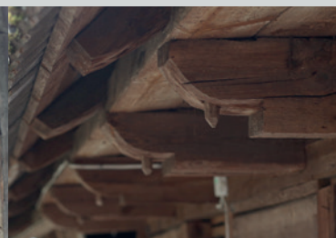
Konstrukcja okapu dachu w budynku gospodarczym, Ponurzyca, gm. Celestynów
